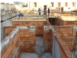
Construcția noii clădiri internat-cantină
