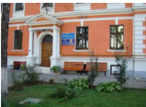
Fațada principală a liceului
