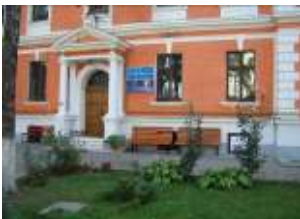
Fațada principală a liceului
