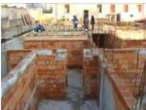
Construcția noii clădiri internat-cantină
