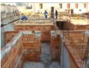
Construcția noii clădiri internat-cantină
