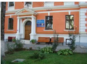
Façada principală a liceului
