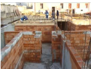
Construcția noii clădiri internat-cantină
